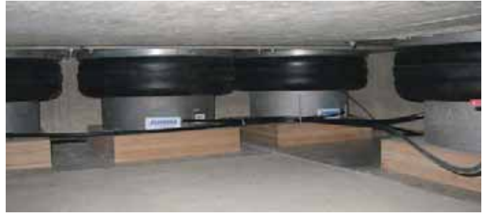
气囊型气浮式减振器能够提供低的固有频率和大的动态位移行程。
